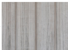
Vulcan Sioo:x Weathered exterior install
