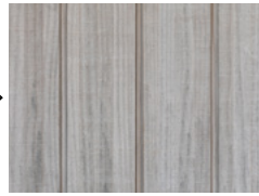
Vulcan Sioo:x Weathered exterior install
